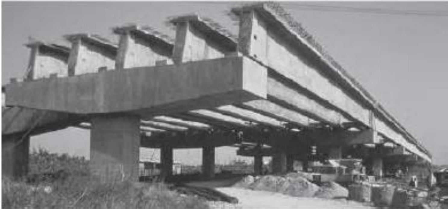
Montaža podužnih nosača čitavog raspona
